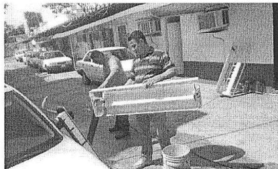
Se realizó el mantenimiento de limpieza con líquido desincrustante foam cleaner al clima de cabina de radio en la Sala de Sesiones
