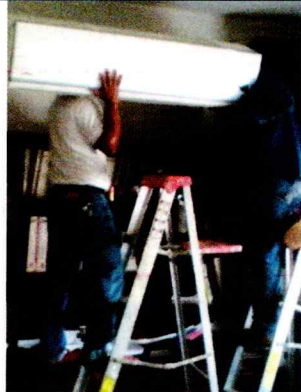
Desmantelamiento de un equipo de aire acondicionado tipo mini Split en la oficina del Secretario Ejecutivo.
