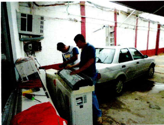
Limpieza de un aire acondicionado tipo mini-split de la Coordinación de Recursos Financieros.
