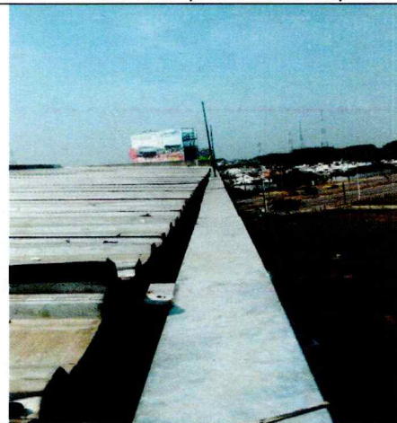
Canal de lámina en corrección.
