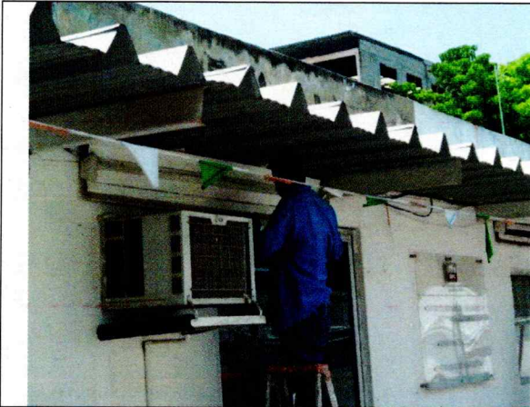
Reparación de las lámparas que se encuentran en la parte exterior de las oficinas de la Coordinación de Educación Cívica (cambio de balastos y tubos).
