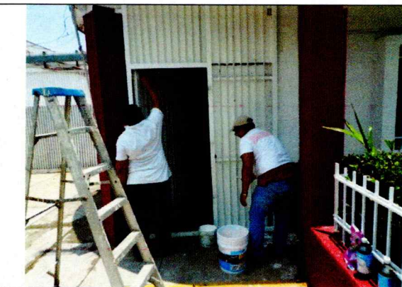
Limpieza y mantenimiento de pintura a la herrería de la subestación eléctrica.
