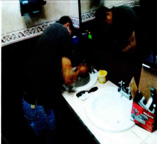
Reparación de lavabo (baño de mujer planta baja).
