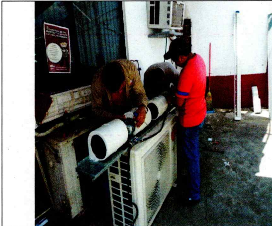
Limpeza a los aires acondicionados tipo mini Split industrial de techo de la Sala de Sesiones.
