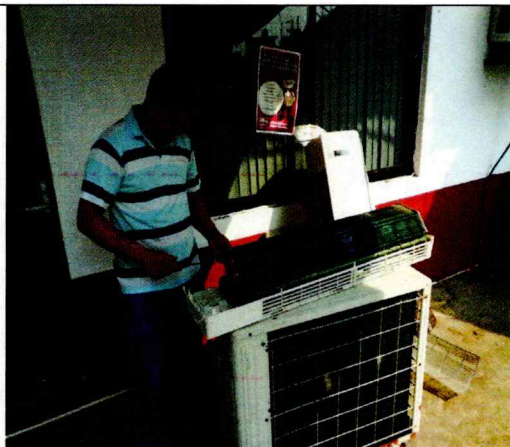
Mantenimiento de limpieza a dos climas tipo mini-split de los servidores del IEPCT.
