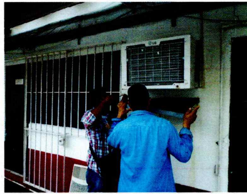
Mantenimiento de limpieza con agua a presión y liquido desincrustante foam cleaner a un aire acondicionado tipo ventana de la Coordinación de Prerrogativas y Partidos Políticos.
