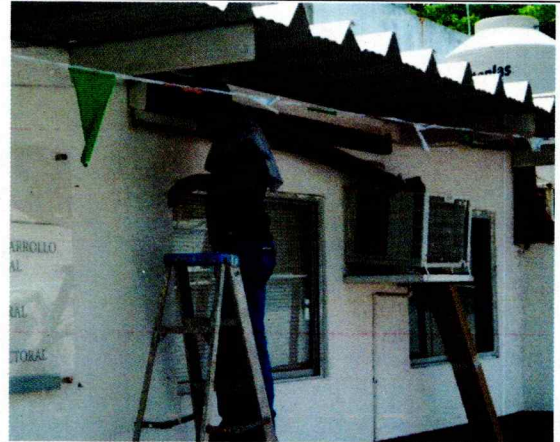
Reparación de las lámparas que se encuentran en la parte exterior de las oficinas de la Coordinación de Educación Cívica (cambio de balastos y tubos).
