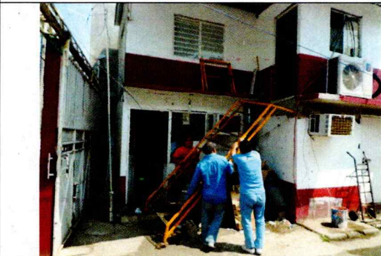
Desmantelamiento de una escalera para la modificación de la misma en el área nueva asignada al OSFE.
