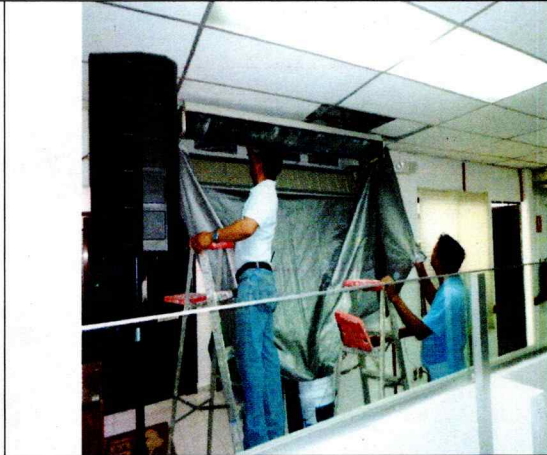
Limpeza a los aires acondicionados tipo mini Split industrial de techo de la Sala de Sesiones.
