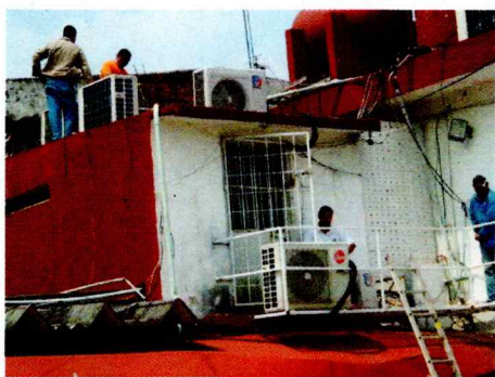
Desmantelación de dos equipos de aire acondicionado tipo mini-split en los servidores.
