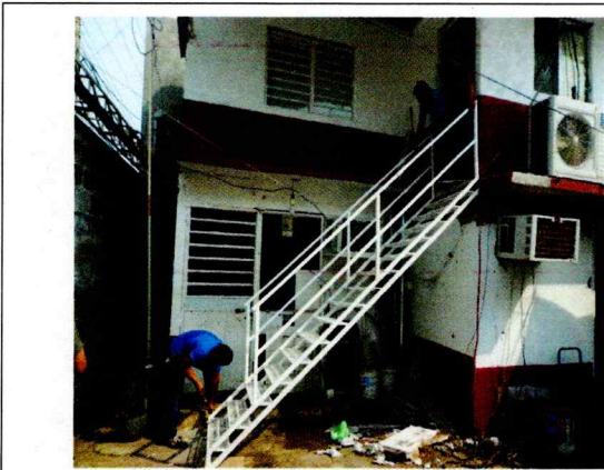
Colocación de una escalera de herrería en las nuevas oficinas del OSFE.
