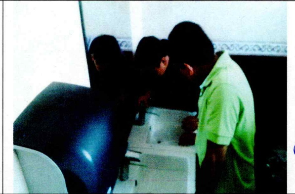
Reparación de los lavabos de los baños de planta baja
