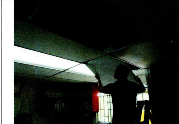
Cambio de placas de unisel y acrílicos del alumbrado en el techo de la Coordinación de Recursos Humanos.
