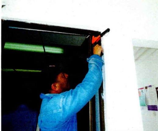
Reparación de la puerta de aluminio de acceso a fotocopiado (colocación de remaches en el marco de la misma).
