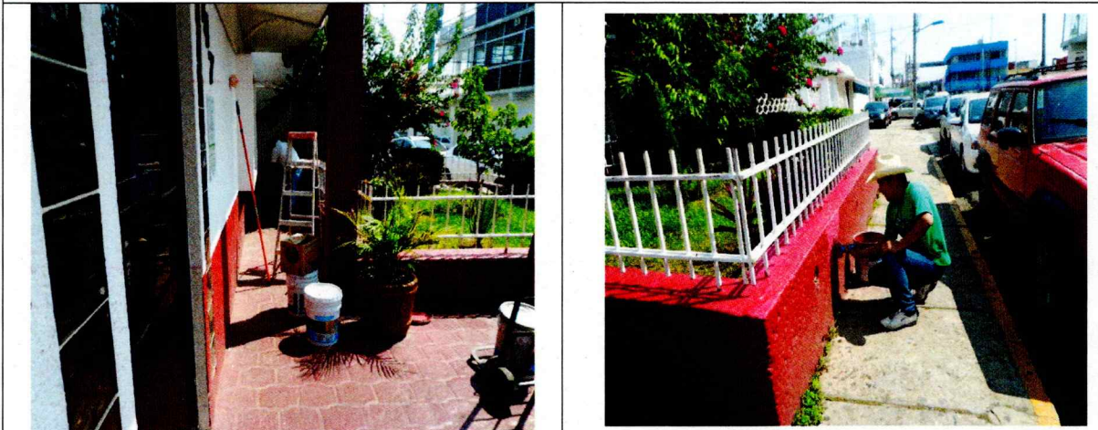
Mantenimiento con pintura acrílica al acotamiento de los jardines que se ubican en la calle Eusebio Castillo.
