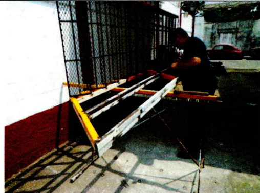
Fabricación de una escalera de material de herrería para las oficinas del OSFE.
