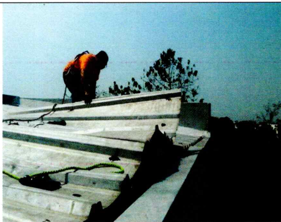
Colocación del ducto del drenaje de agua en el techado del edificio de periférico.
