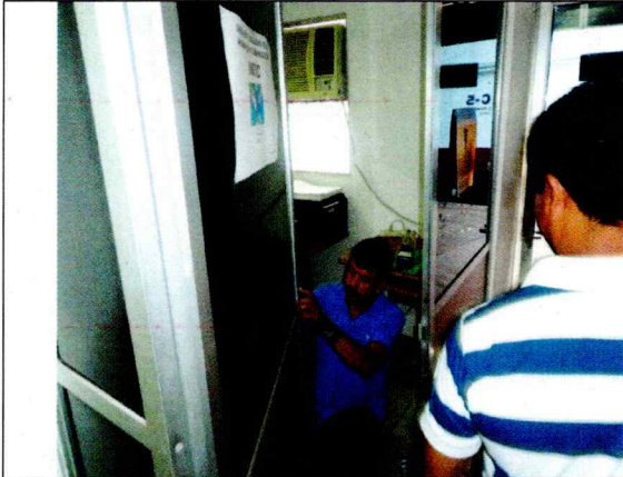
Cambio de cerradura de la puerta del privado de la UNITIC.
