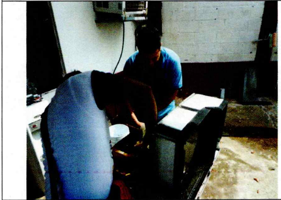
Mantenimiento de limpieza con agua a presión y liquido desincrustante foam cleaner a un aire acondicionado tipo ventana de la Coordinación de Prerrogativas y Partidos Políticos.
