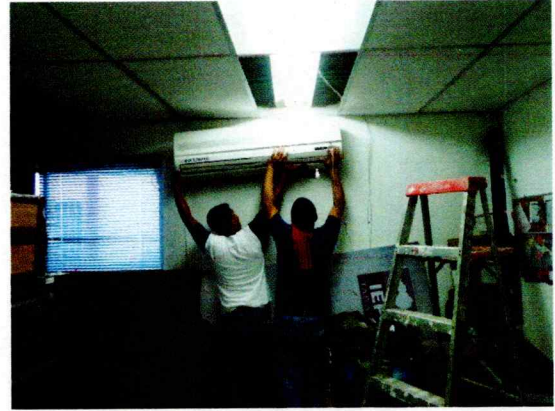
Limpieza de un aire acondicionado tipo mini-split del área de radio y televisión perteneciente a la Unidad de Comunicación Social.
