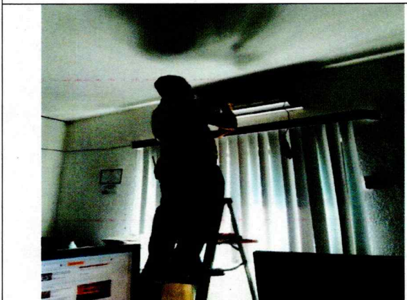
Limpieza al aire acondicionado tipo mini Split de la Secretaría Ejecutiva.
